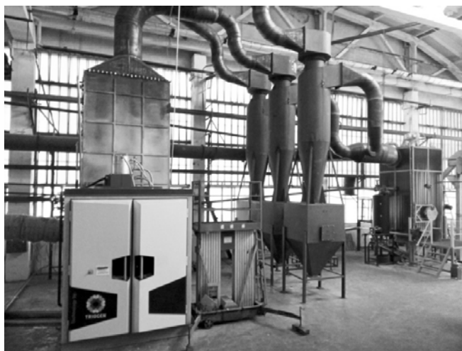
Рисунок 5 – Теплогенератор кипящего слоя и турбогенератор с органическим циклом Ренкина
